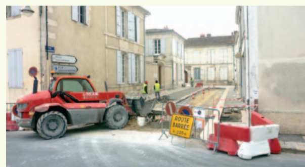
Fin des travaux de la rue Fourgeaud.
