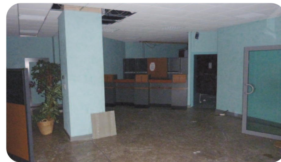
L'accueil du bâtiment avant sa réhabilitation
