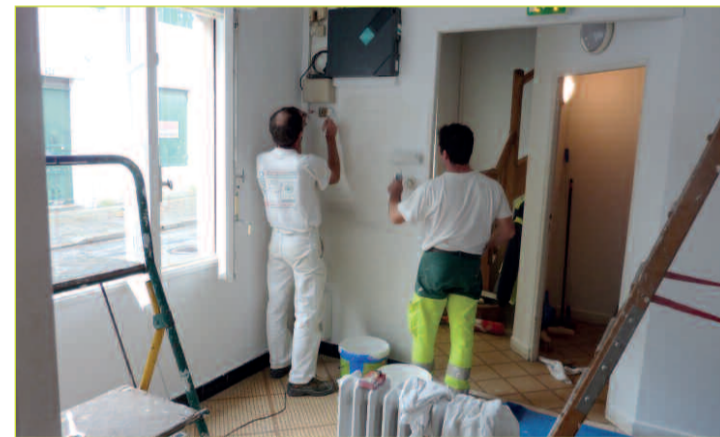
Réfection des anciens bureaux vétérinaires
